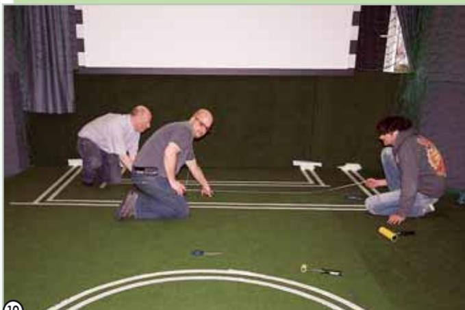
10 Jetzt fehlt nur noch die nötige Spielfeldmarkierung. Diese wird zunächst vorgezeichnet und großzügig abgelebt, bevor der Raum zwischen den Klebestreifen mit weißem Sprühlack ausgefüllt wird. Nach einer Trocknungszeit von etwa einer Stunde können die Klebestreifen dann wieder entfernt werden
